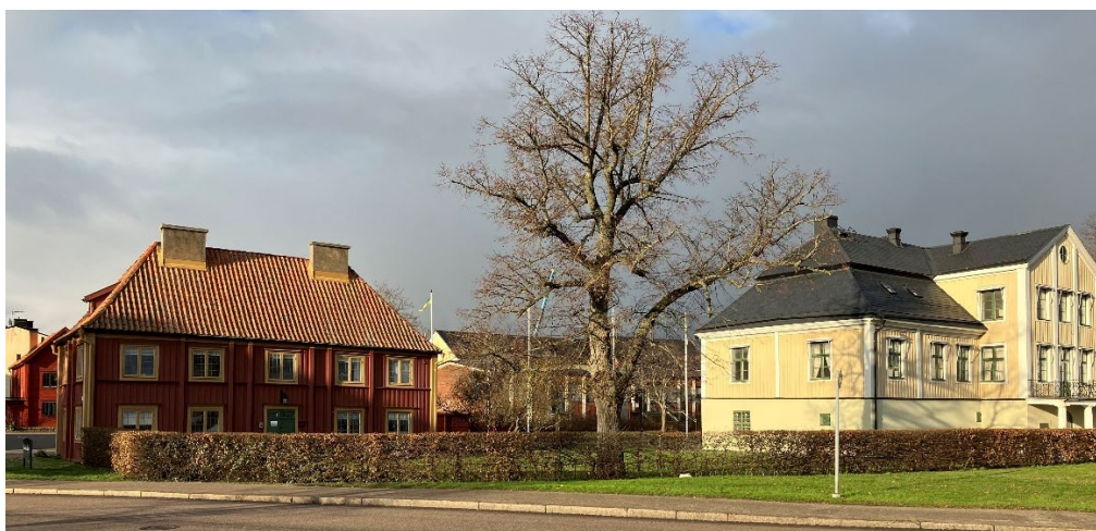
Bild 24. Byggnadsminnesförklarad bebyggelse (Palanderska gården) på angränsande fastighet Hubendick 3.
