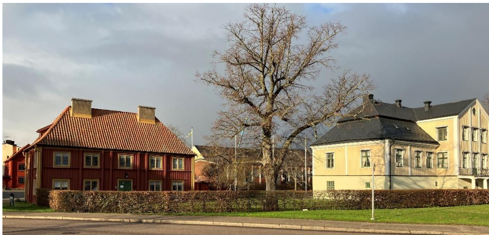
Bild 25. Byggnadsminnesförklarad bebyggelse (Palanderska gården) på angränsande fastighet Hubendick 3.
