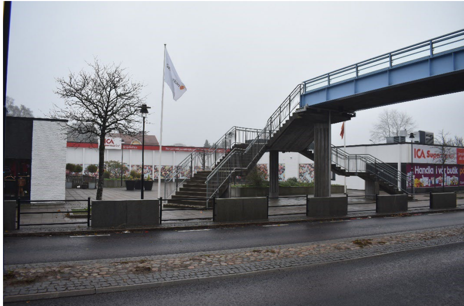
Bild 13. Gångbron över Västra Riksvägen sett från planområdet.
