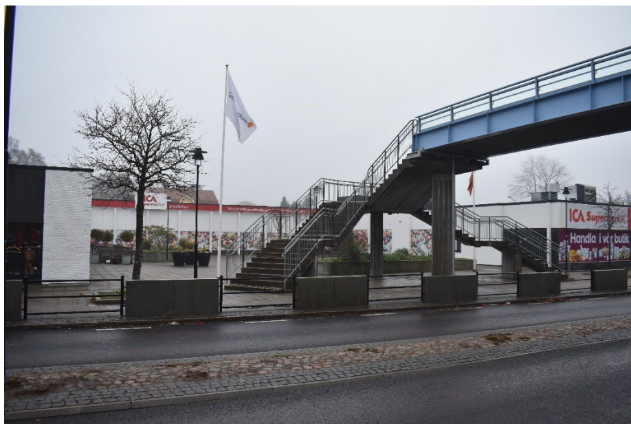
Bild 13. Gångbron över Västra Riksvägen sett från planområdet.
