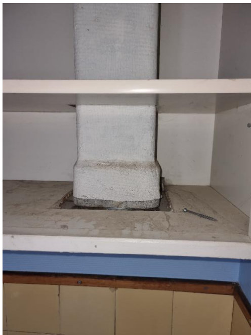
Figur 19 Imkanal i eternit
