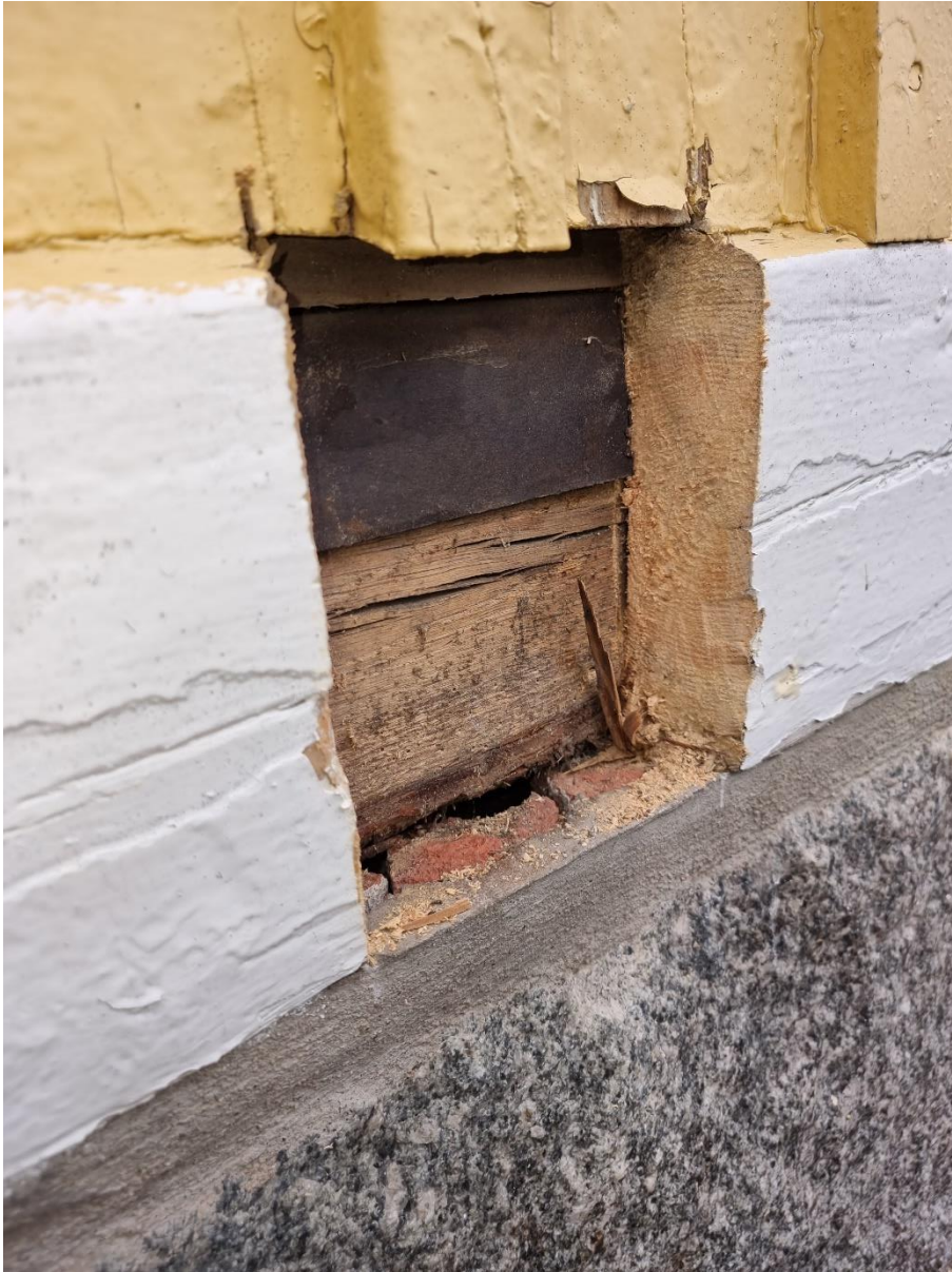
Figur 15 offerbräda och bakomliggande timmerstomme
