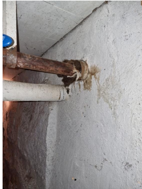
Figur 11 förmodad asbestfiber
