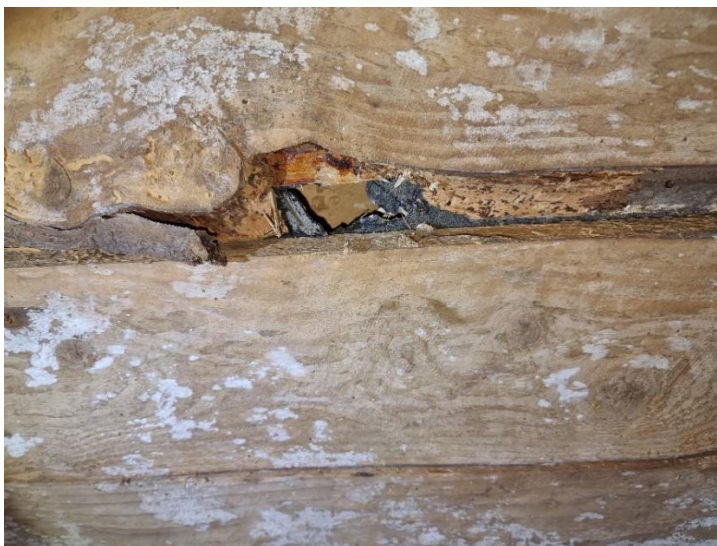
Figur 25 bjälklag med tjärpapp och sågspån
