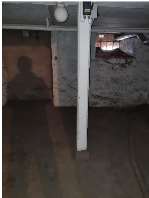
Figur 13 vitkalkade källarväggar, igensatt källaröppning
