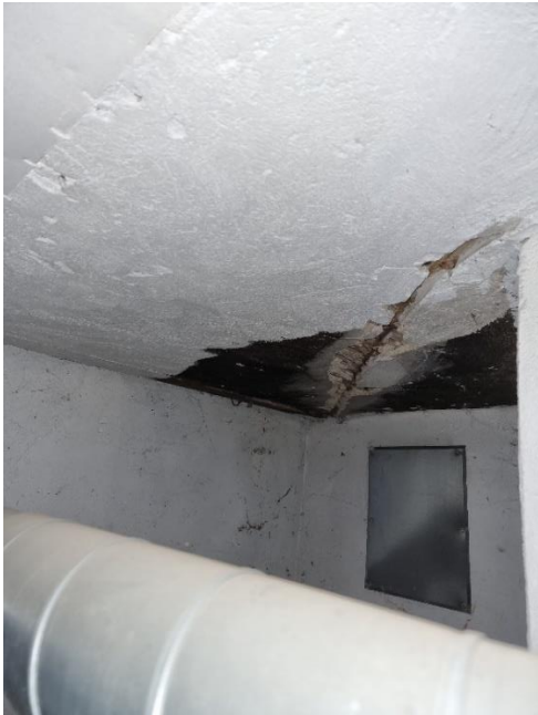
Figur 10 reveterad puts
