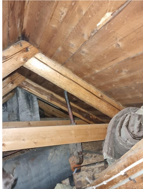
Figur 17 Ny takregel infäst på bef. takstol
