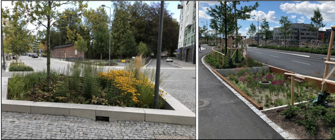
Figur 8. Exempel på nedsänkta regnbäddar (Foton: Norconsult).
