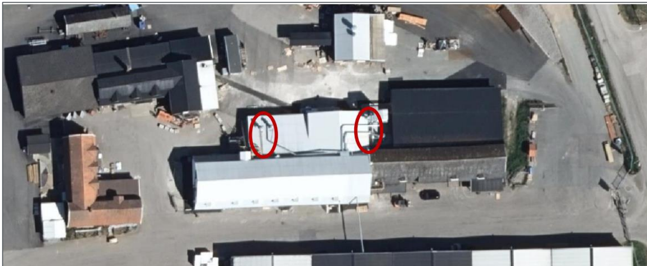
Figur 8. Fläktar på byggvaruhandel (XL-BYGG).
