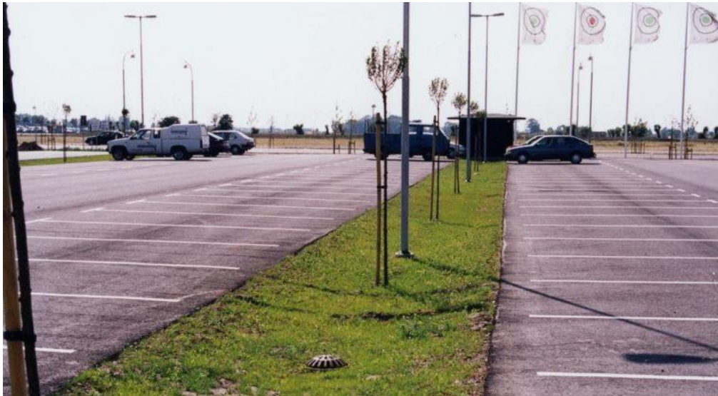
Figur 15. Ett anlagt svackdike vid en parkering i Svågertorp. 13
