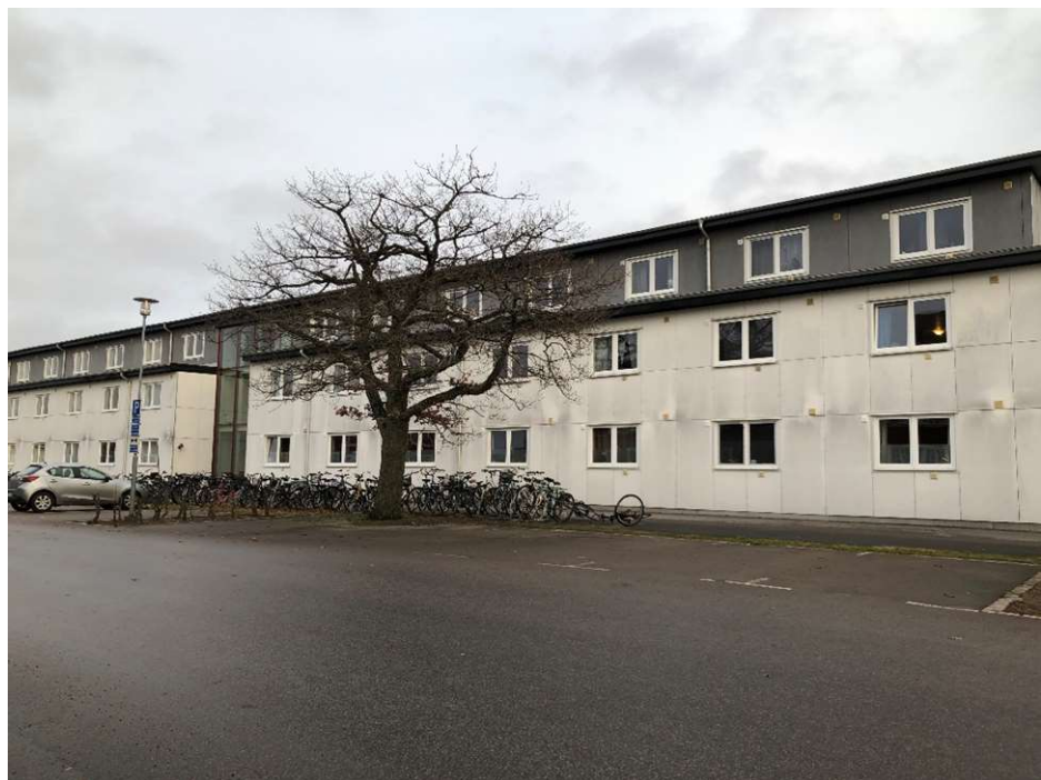
Bild 8. Befintlig bebyggelse på fastigheten Grenadjären 57.
