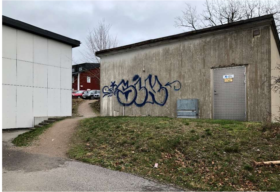
Bild 59. Befintlig transformatorstation inom planområdet.
