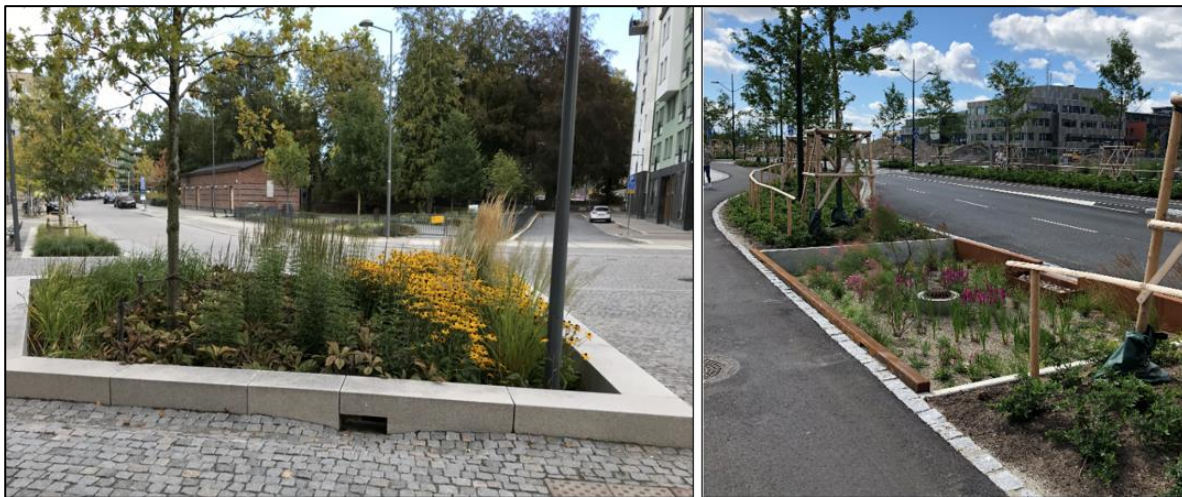
Figur 21. Exempel på nedsänkta regnbäddar (Foton: Norconsult).
