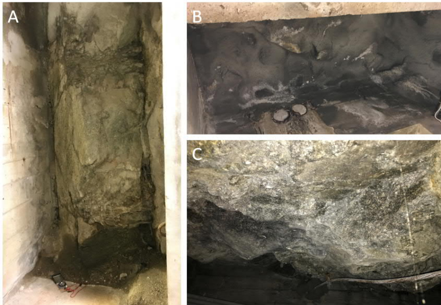
Figur 7 Bild A visar höger sida och bild B visar taket efter portalen, Nr 1. Bild C visar berget vid Nr 2.
