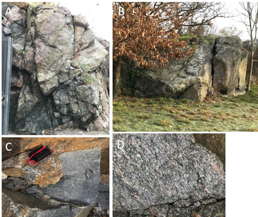
Figur 6 Bild A berghäll utanför huvudingången till bergrummet med band av mafisk bergart. Bild B visar en större håll av homogen granit, ca 30 m norr om bergrummet. Bild C visar en närbild på mer finkorniga, tonalitiska inslag nära nödutgången och bild D visar närbild på den ögonförande, gnejsiga graniten.
