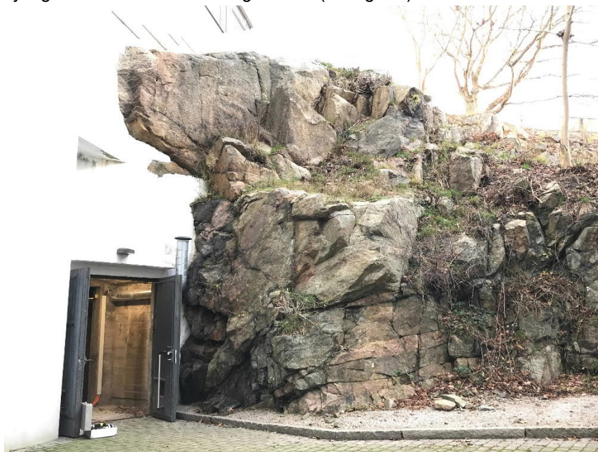
Figur 1 Ingång till bergrummet
