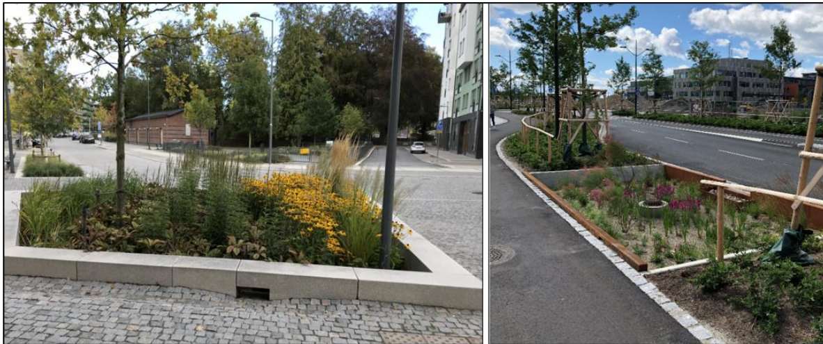
Figur 21. Exempel på nedsänkta regnbäddar (Foton: Norconsult).
