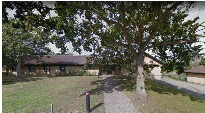
Bild 3. Planområdet utgörs idag en f.d. kontorsbyggnad i ett plan samt komplementbyggnad.
