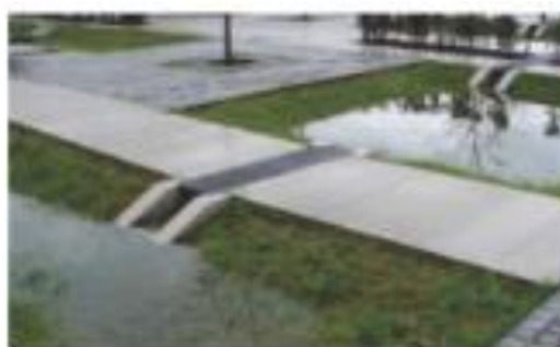
Figur 24 Avledning under gångväg
