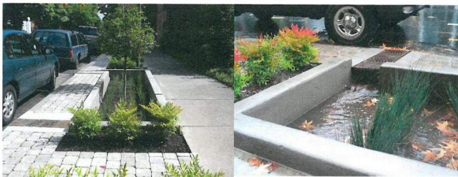
Figur 20 - Rain Gardens vid torrtilfälle och regntillfälle i anslutning till trottoar och gatuparkering, (Neptunigatan biofilteranläggningar (ex från USA) VASYD 2014).
