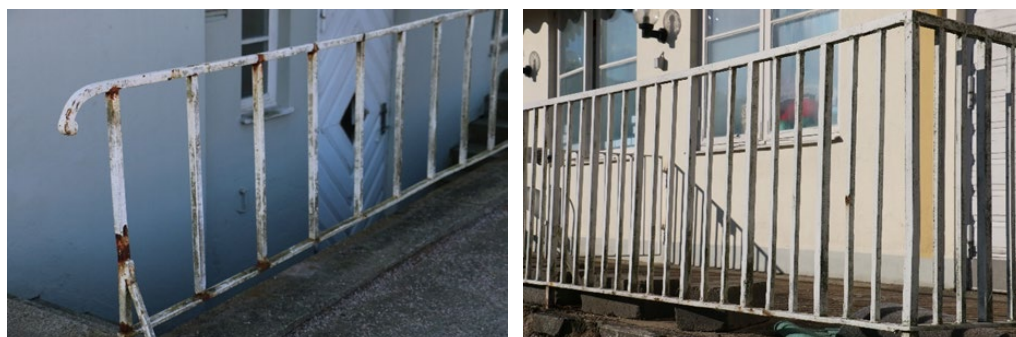
T.v. räcke på norra gaveln med det ursprungliga utförandet och t.h. räcket vid huvudfasadens altan som förtätats.
