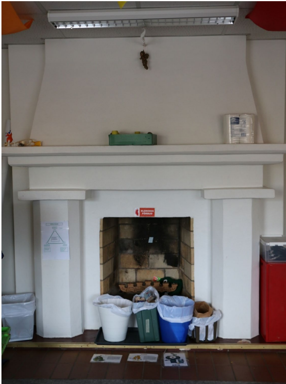
Ursprunglig eldstad som bevarats i matsalen på nedervåningen.
