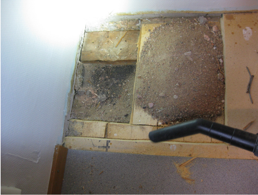
Bjälklag i rum 2110
