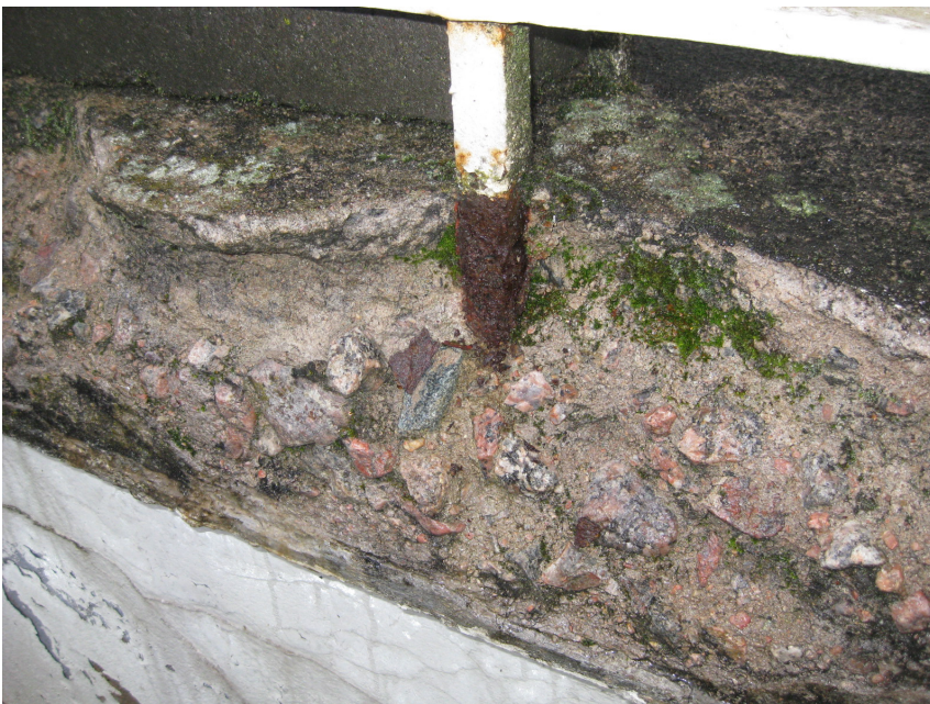
Räckesinfästning till balkong östra fasaden
