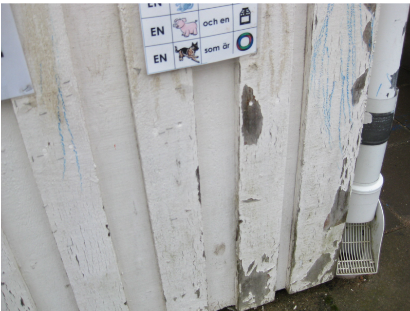
Vindfång på söderfasad
