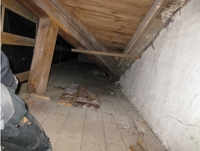
Yttertakskonstruktion (sidovind vindsvåning)
