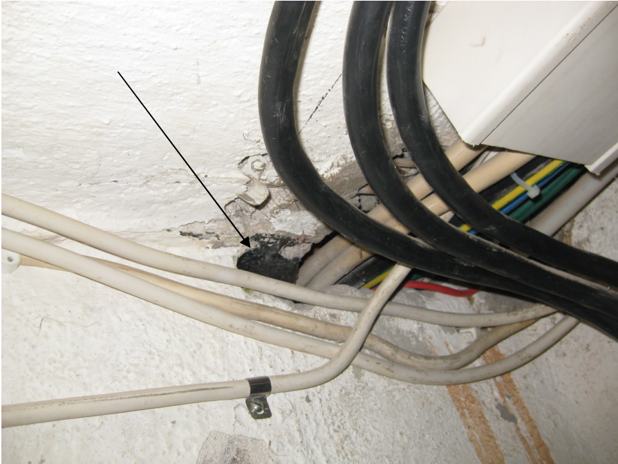
Tjärpapp mellan källarvägg och bottenbjälklag
