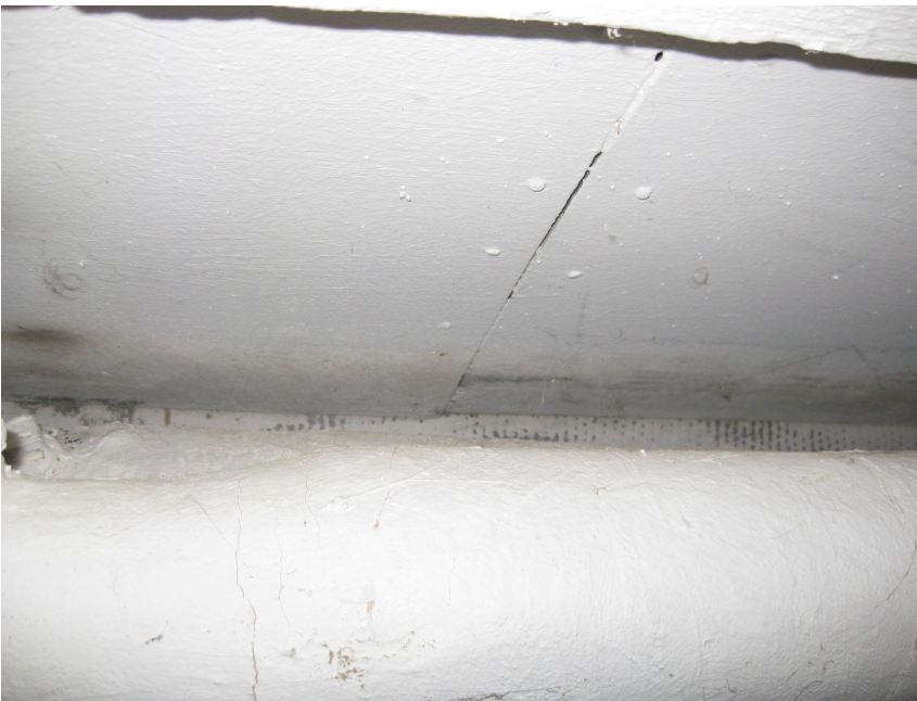
Asbestcementskiva (eternit) i tak
