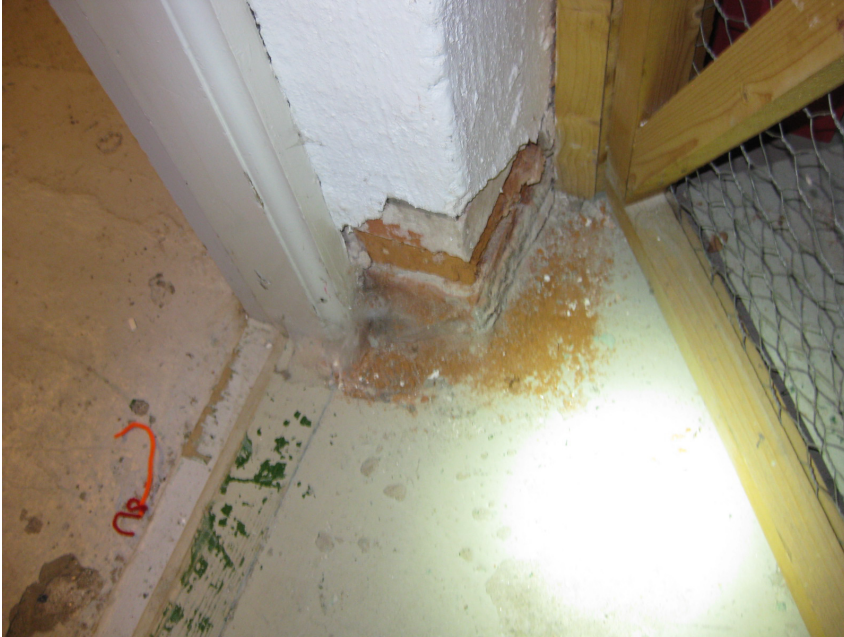
Putssläpp på källarvägg
