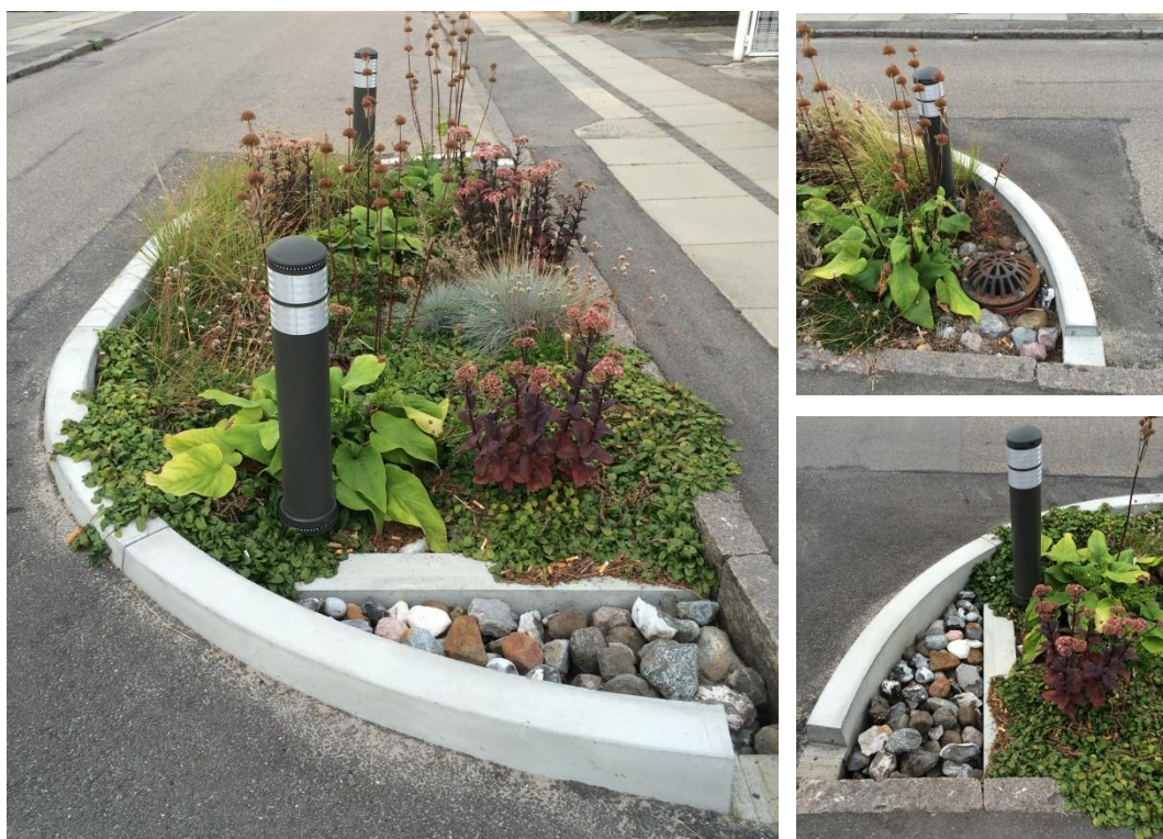
Figur 18: Bio-retention cell vid Lindevång, Brøndby (Foto: Morten Kjølbj, DHI).
