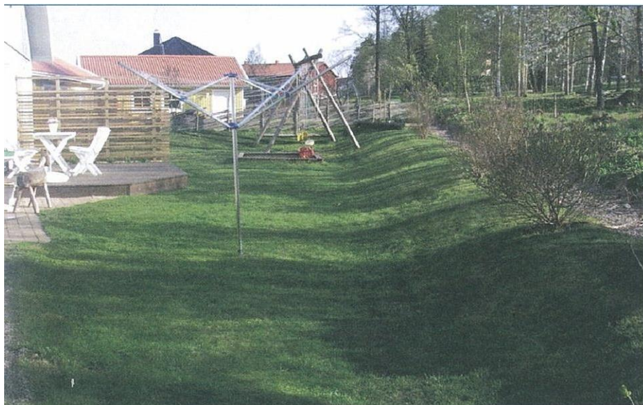
Figur 23: Exempel på avskärande dräneringsstråk (Svenskt Vatten P105).
