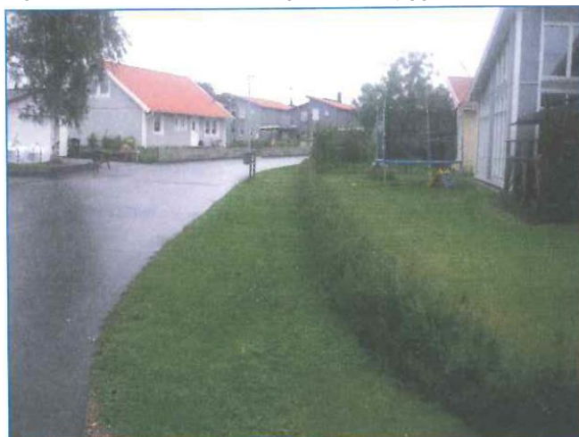
Figur 20: Infiltrationsstråk försett med en gräsyta över en grus- och makadamfyllning, Halmstad (Foto: Svenskt Vatten P105).
