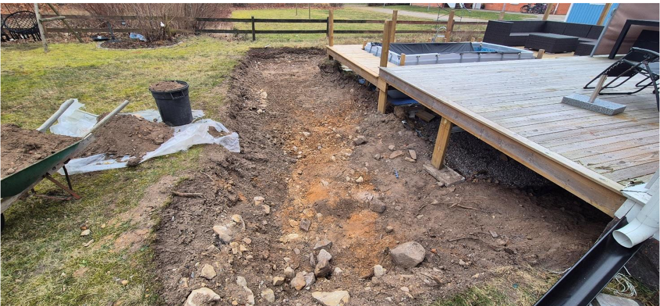
Figur 9. Östra schaktväggen efter ytterligare schaktsanering 2025.
