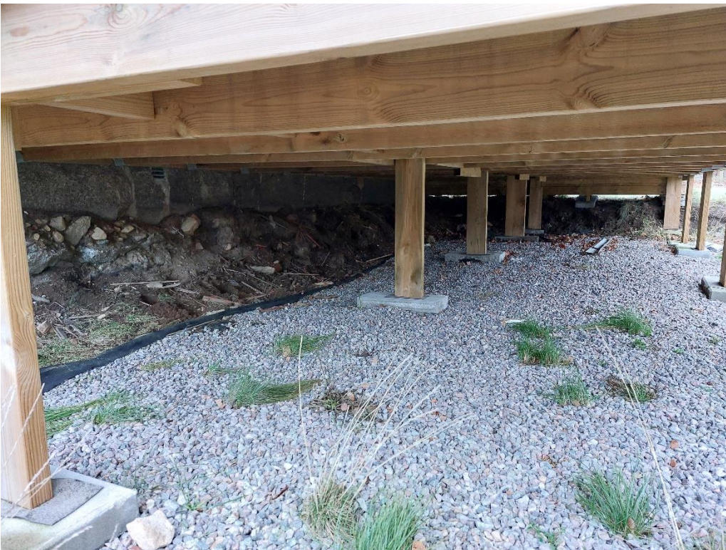
Figur 7. Fotat från väster under altanen. Norra schaktväggen syns till vänster i bild.
