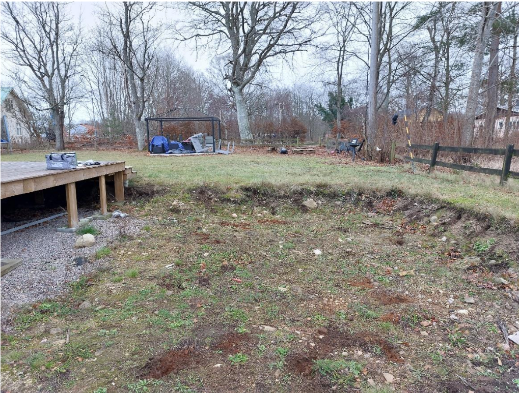
Figur 2. Schaktets södra schaktvägg syns till höger i bild.
