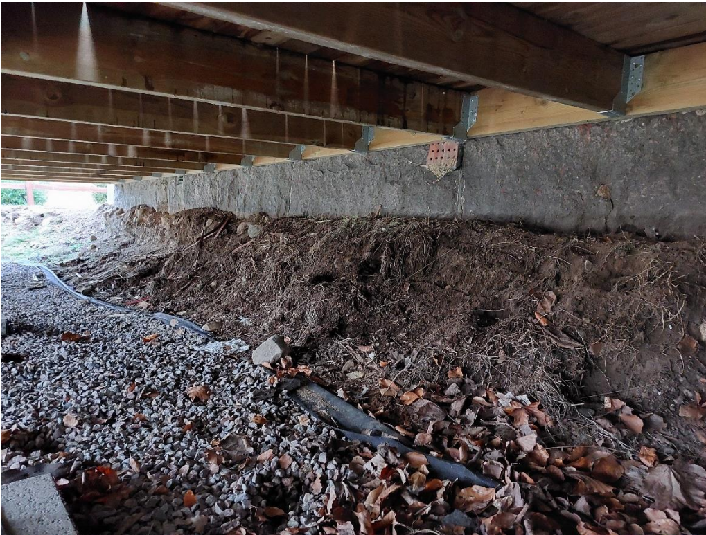
Figur 6. Norra schaktväggen, under altanen.
