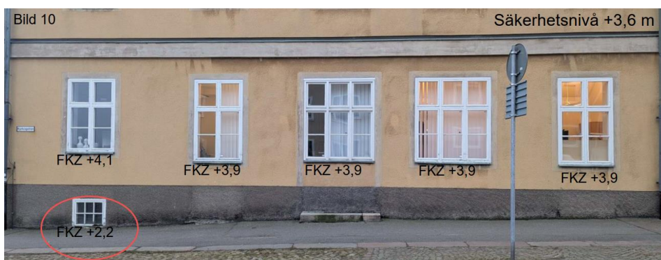
Figur 13. Bilder med höjdmätningar (meter RH2000) av objekt med potentiell risk för översvämning (bild 7–10). Bildens läge visas i Figur 12. Objekt med risk för översvämning är inringade i rött. Gh = golvnivå, FKZ = underkant fönsterkarm, DKZ = underkant dörrkarmnivå, och BTZ = betongplattanivå.
