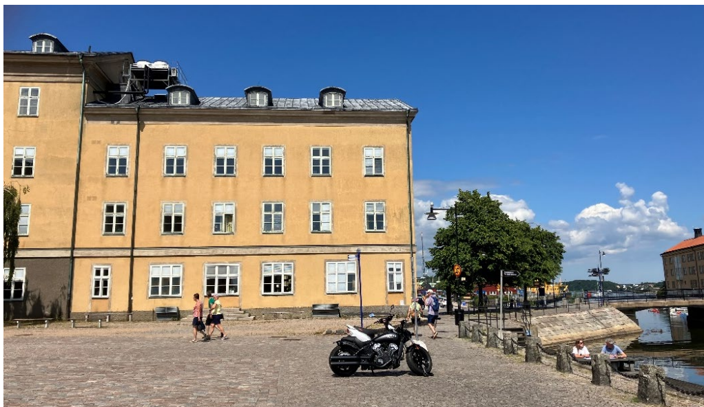
Bild 6. Den östligaste delen av kasernen i tre våningar nära Stumholmskanalen.
