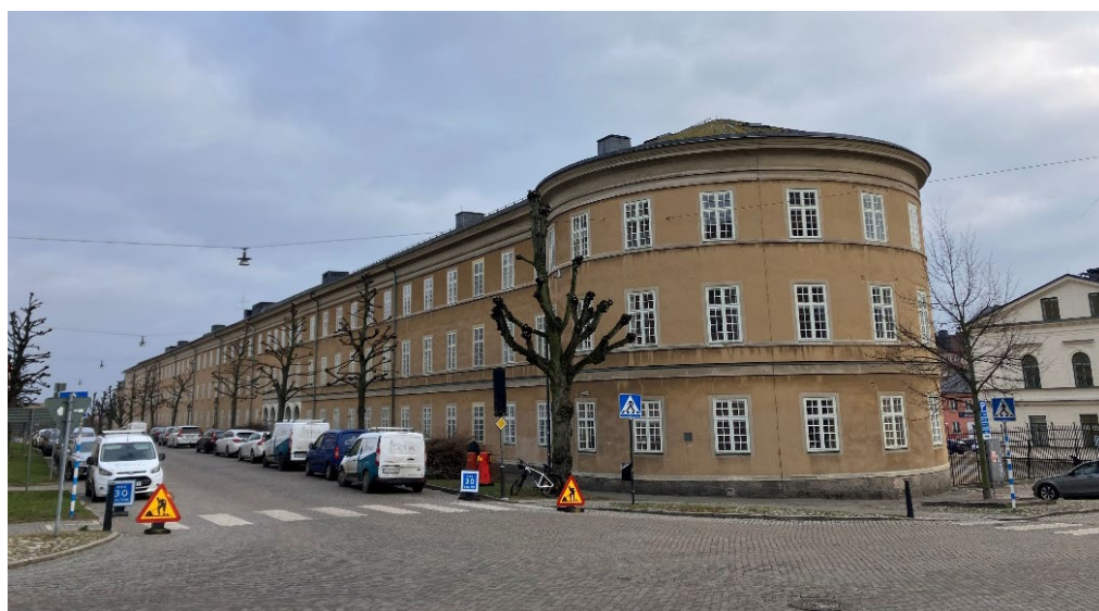
Bild 4. Kasernbyggnaden sett från Drottninggatan.
