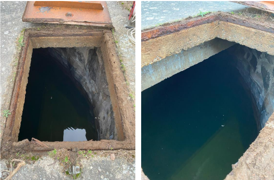
Figur 4. Bild till vänster: Visar krigsbranddammens när luckan är öppen. Bild till höger: Visar den gjutna avsatsen under vattnet tydligare. Källa: Sweco, 2025
