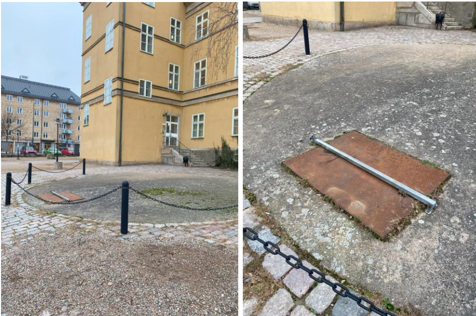
Figur 2. Bild till vänster: Gjuten platta. Bild till höger: Bild av lucka i metall. Källa: Sweco, 2025
