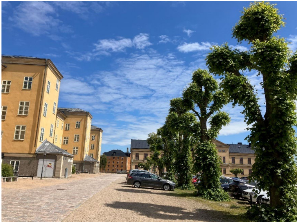
Bild 14. Kasernen med de utskjutande trapphusen, som bildar gårdsmiljöer i anslutning till det stenlagda gång- och cykelstråket, sett från väster.
