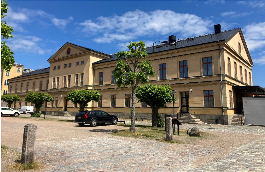
Bild 8. Angränsade bebyggelse till planområdet med det f.d. militära kokhuset i öster.
