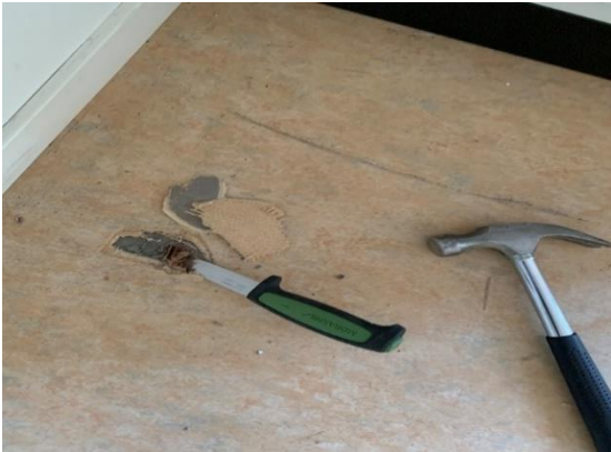
Figur 3. Dubbla lager ytskikt (linoleummatta på plastmatta). (Sweco, 2024)
