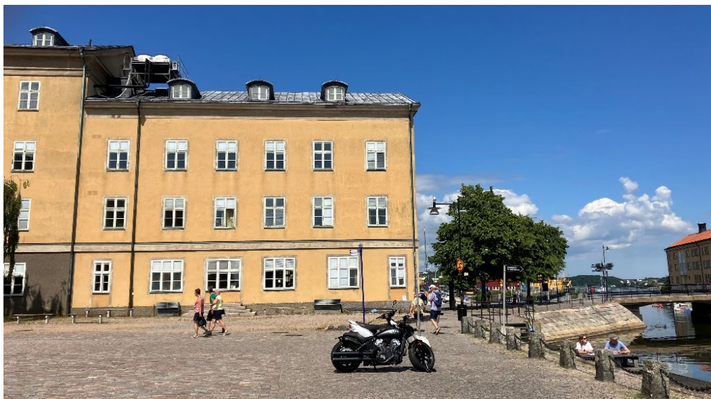
Bild 6. Den östligaste delen av kasernen i tre våningar nära Stumholmskanalen.
