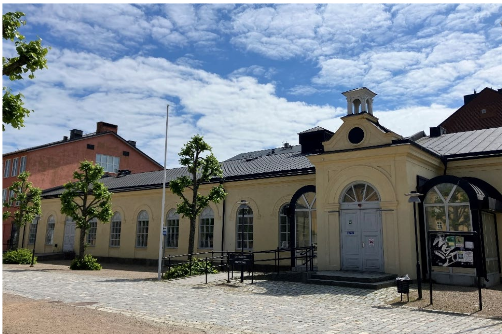
Bild 9. Bebyggelse söder om kaserngården med f.d. exercishall och skolbyggnad.
