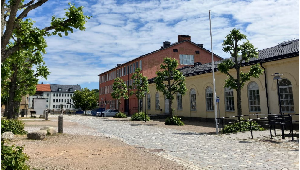
Bild 10. Bebyggelse söder om kaserngården med f.d. exercishall och skolbyggnad. Nuvarande Sparresalen och lokal för Marinens musikkår.
