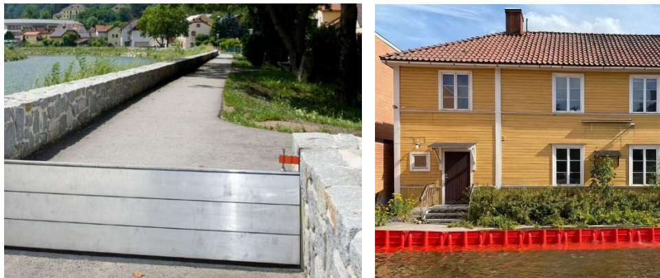
Bild 98. Exempel på mobila översvämningsskydd i aluminium och i plast.
