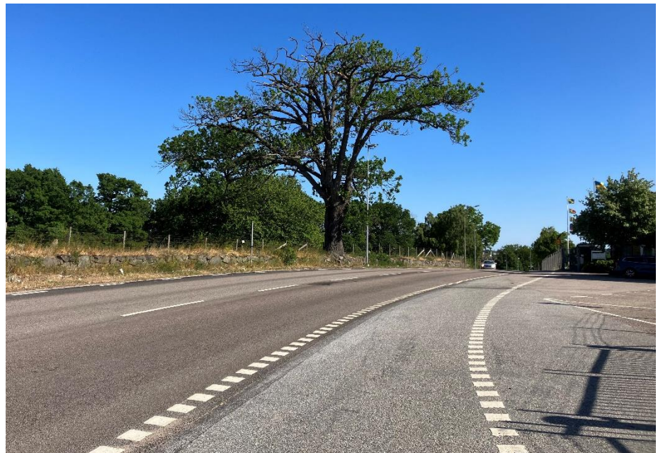
Bild 15. Gullbernavägen och parkeringsytan utanför fastigheten Telefonen 1 till höger i bild.
