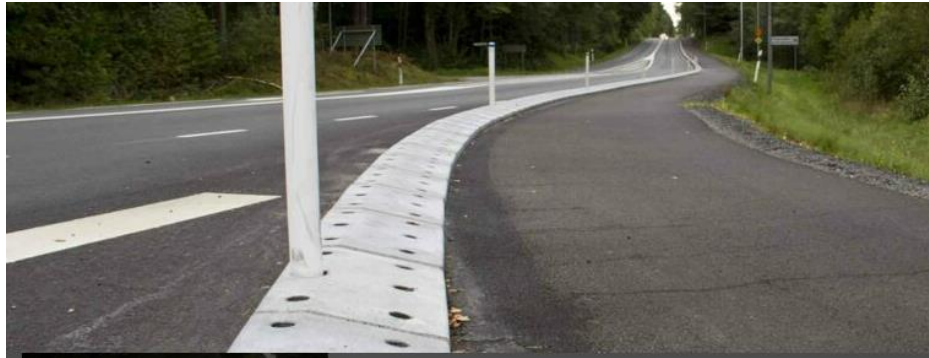
Bild 12. Ett GCM-stöd är ett kantstöd i betong som avgränsar gång- och cykelbanor från vägar och gator.
