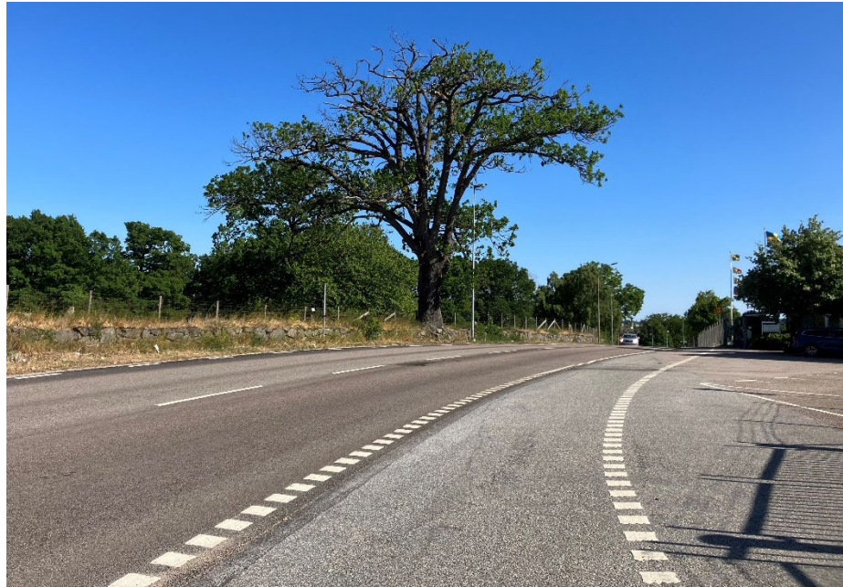
Bild 14. Gullbernavägen och parkeringsytan utanför fastigheten Telefonen 1 till höger i bild.
