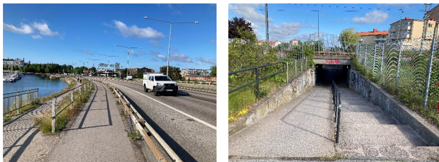
Bild 61-62. Cykelväg öster om Österleden och gång- och cykeltunneln under järnvägen, norr om Brohålan.
