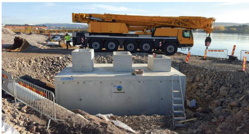
Figur 7 Exempel på dagvattenmagasin med filter anlagt i utfyllnadsområde.
