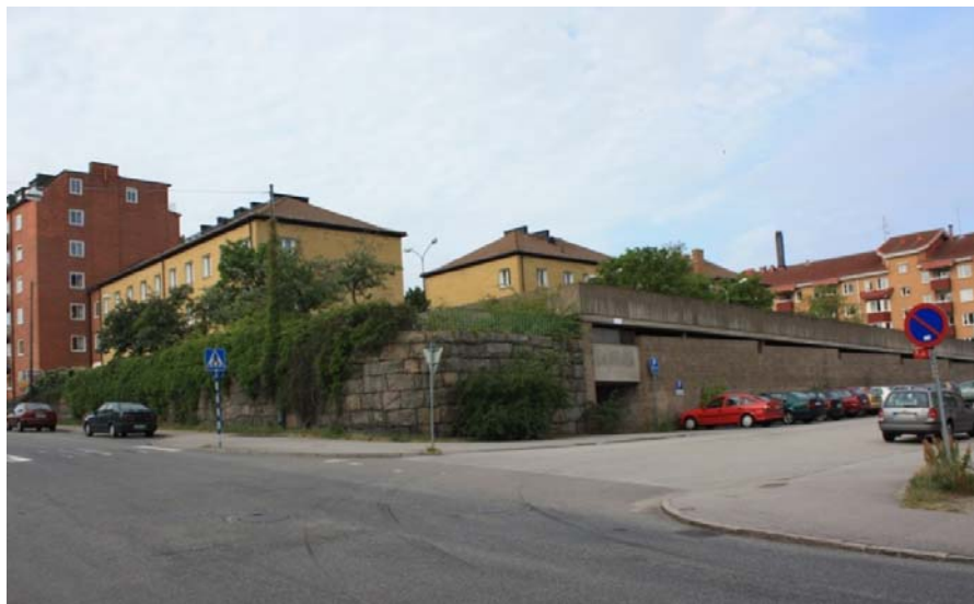
Bild 6. Angränsande bebyggelse söder om fastigheten Barken 1 uppfördes på 1920 respektive 1940-talet i tre våningar.
