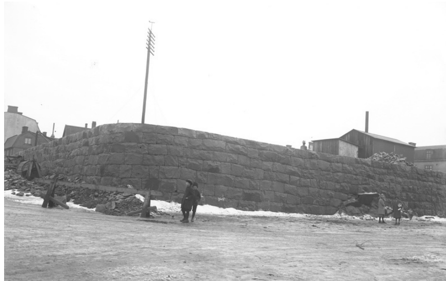
Bild 16. Historisk bild på muren, troligen från 1920/30-tal.
