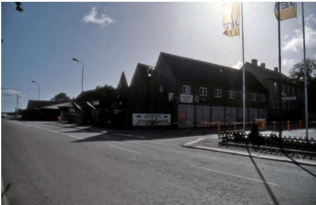
15. 1984. Magasinsbyggnaderna på Humble 2. Notera skyltar "AB Karlskrona bildelar".
