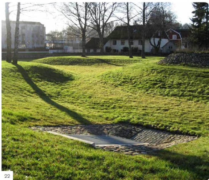
Figur 16. Exempel på utjämningsmagasin/översvämningsyta (Foto: Malin Engström, Växjö kommun).
