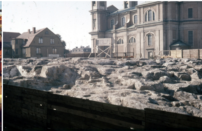
Kvartetet Hjulhammar under rivning, 1959-08-14.
