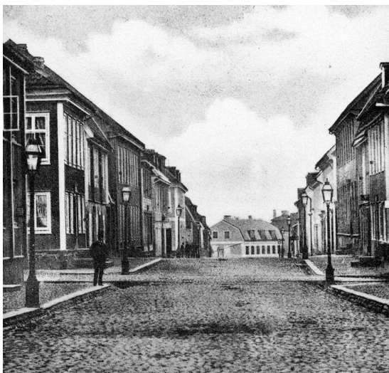
Ronnebygatan före branden 1887.
