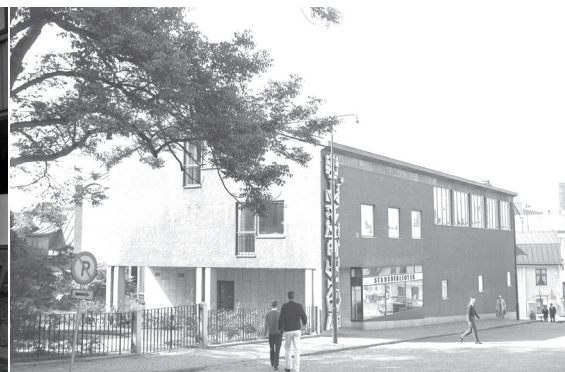
Det nyuppförda stadsbiblioteket i början av 1960-talet.
