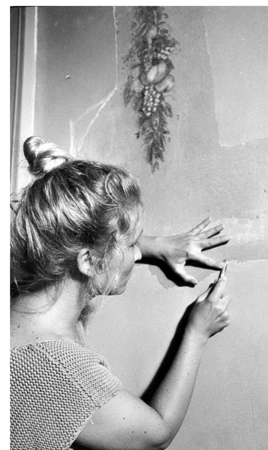
Chapmansskolan renoveras. Marie Olivendal från Blekinge museum med väggarbete. 1989
