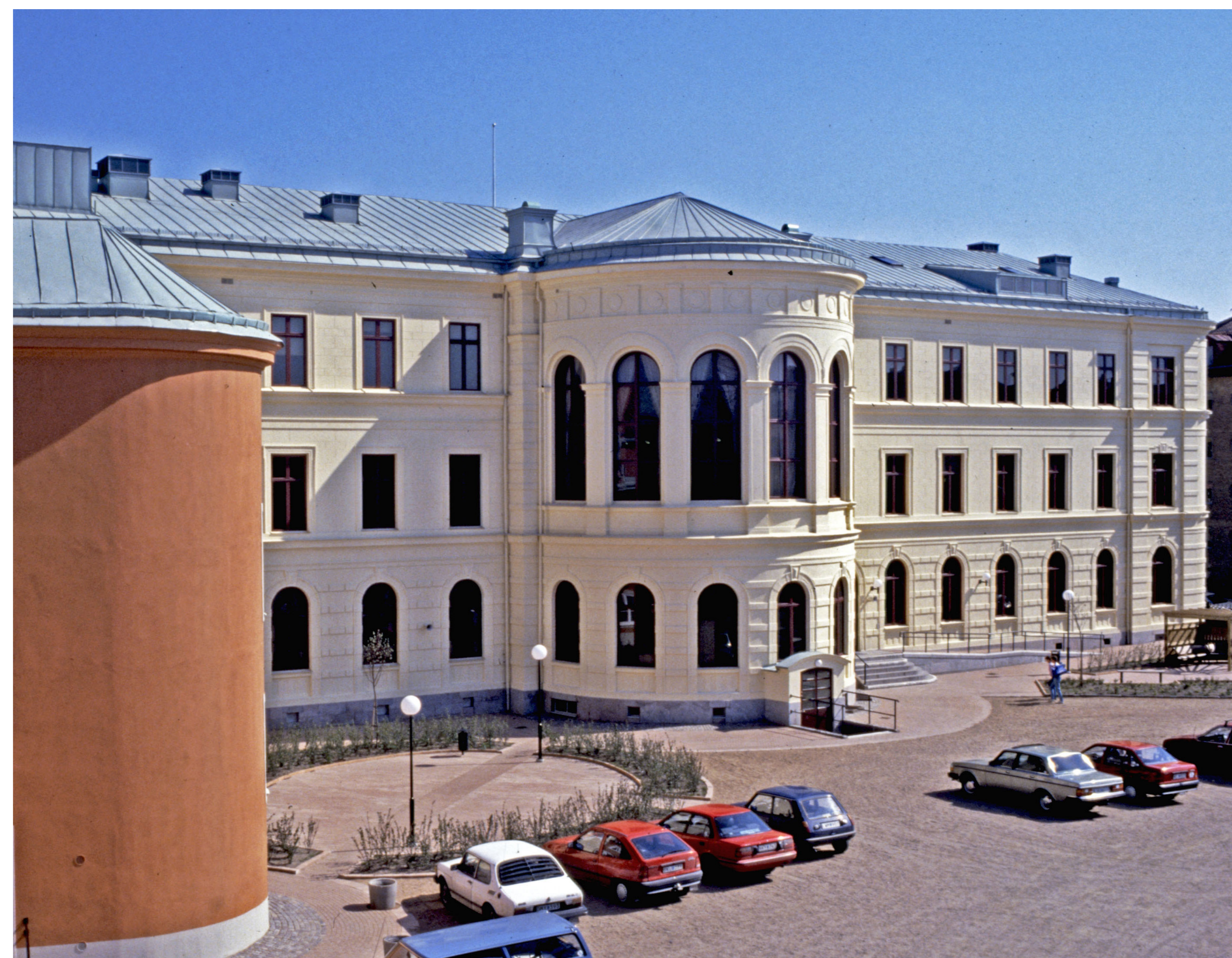
Gårdsfasad efter renoveirng 1990
