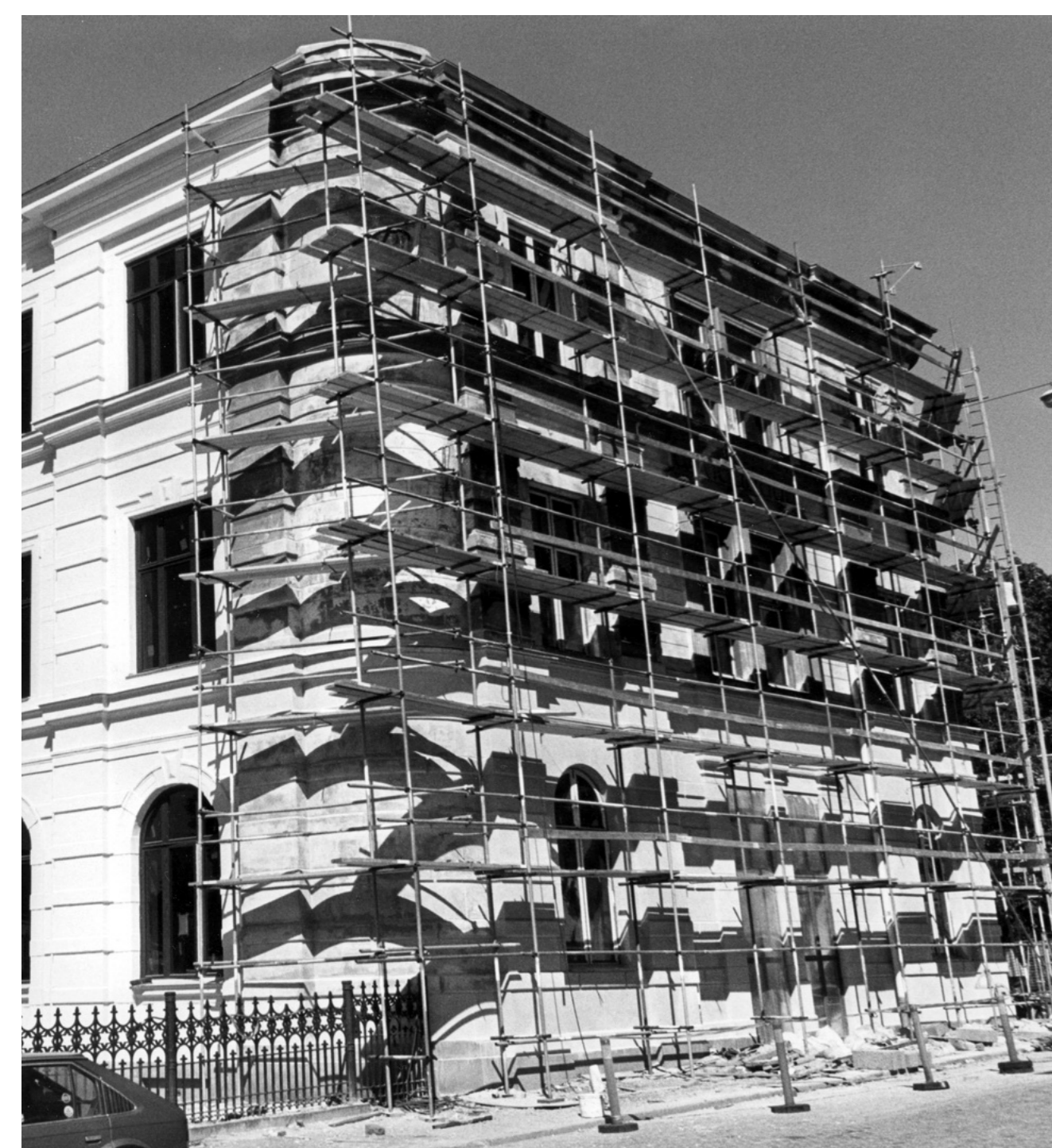
Fasad mot Östra Köpansgatan, under renoveringen 1989.
