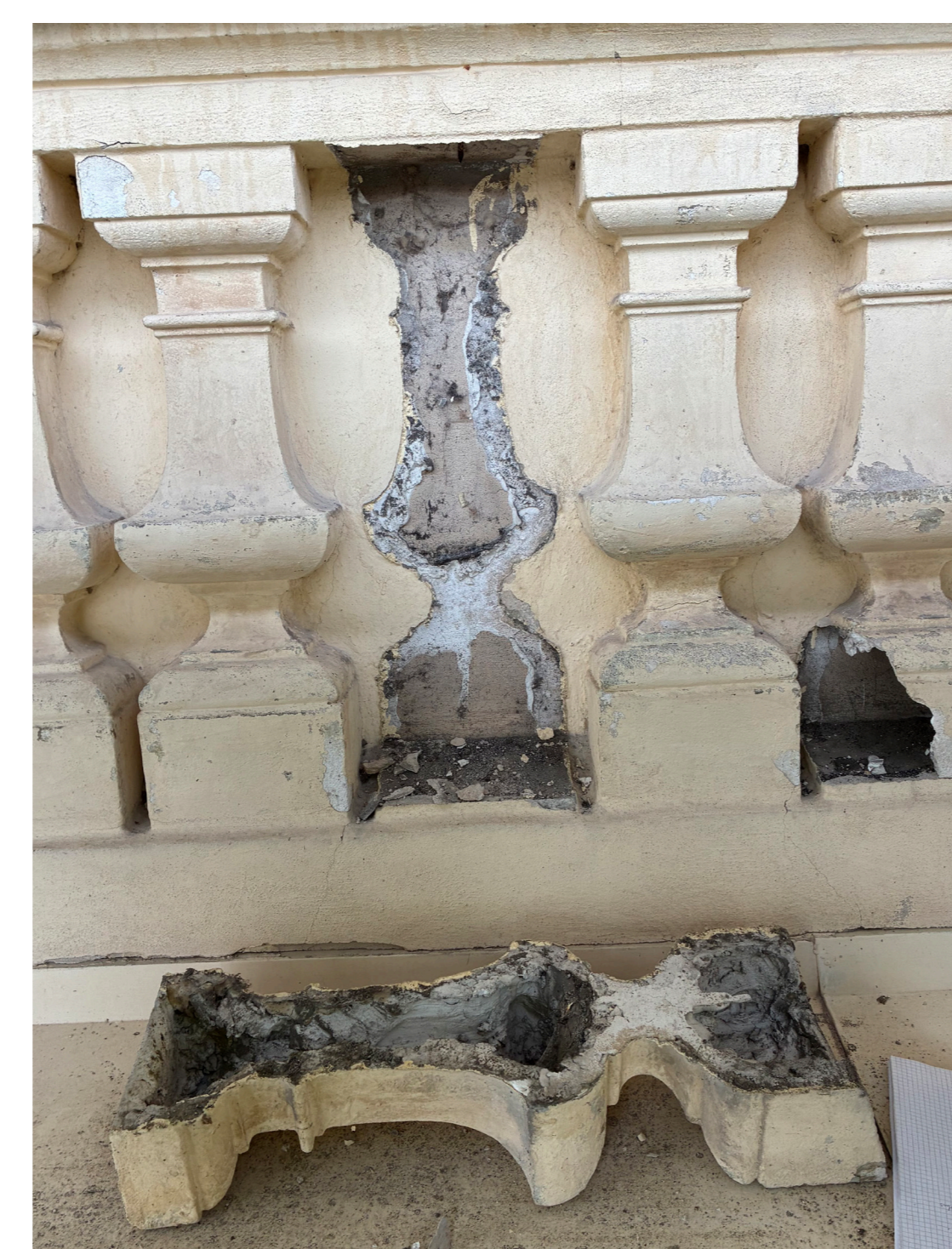
Skadade fasadelement som kommer åtgärdas
