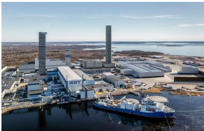
Figur 11: Tornen för kabeltillverkning hos NKT. Kabelutläggningsfartyget i förgrunden. Foto: NKT.se.
