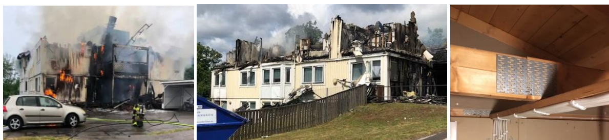
Figur 45: Vid en brand i ett särskilt boende, Ronneby år 2020, överraskades såväl vårdtagarna, personal och Räddningstjänsten av en mycket snabb brandspridning och kollaps av takkonstruktionen. Vid kontroll av en likadan grannfastighet upptäcktes en mängd brister i det byggnadstekniska brandskyddet. Bland annat hade takstolar och andra bärande konstruktionsdelar skarvats endast med spikplåtar. Upptäckten har lett till att samtliga byggnader i området som uppvisade liknande brister har eller kommer att byggas om.
