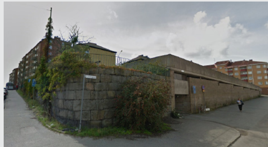
P-däck i kv Barken. Granitmuren närmast i bild är inte rivet. Källa: Google Street View 2019.
