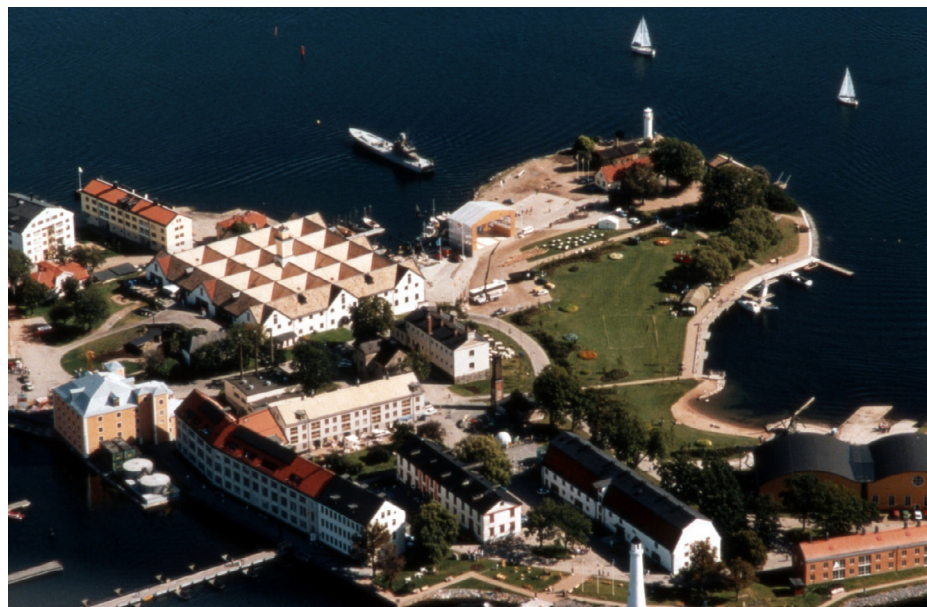
Stumholmen i mitten av 1990-talet. Marinmuseum som stod klart 1997 har ännu inte börjat byggas. Bostadshuset som uppfördes till bomässan 1993 är synliga i bilden. Bildkälla Blekinge museum.
