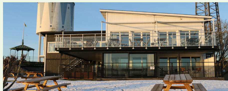
Den äldre, svarta restaurangbyggnaden syns till vänster, och tillbyggnaden i vitt till höger. Foto: Karlskrona kommun 2023.
