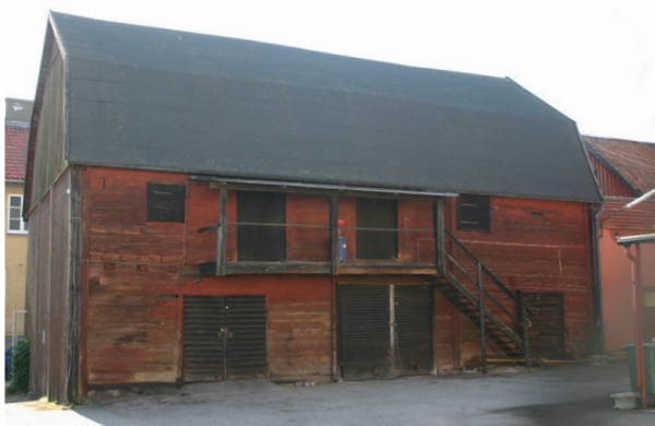
Hamnmagasin med brutet tak som låg längs Arvid Nilssonsgatan, norr om det idag bevarade magasinet. Foto från gårdssidan 2010. Källa: Blekinge museum.
