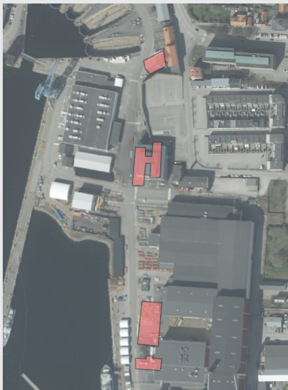
Röda markeringar visar var de rivna byggnaderna låg.
