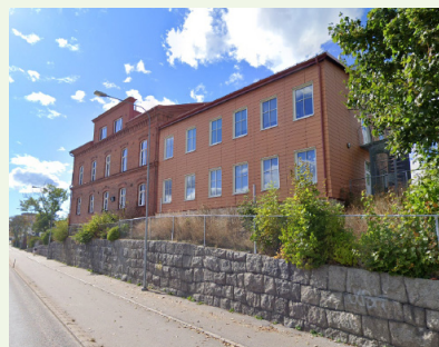
Tullskolans tillbyggnad mot Sunnavägen. Google Street View 2022.
