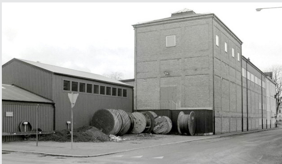
Hörnet Spårgatan - Norra Smedjegatan år 2003. Den låga byggnaden till vänster skulle revs när en ny kontorsbyggnad skulle uppföras. Foto: Jonas Eckerbom. Källa: Blekinge museum.
