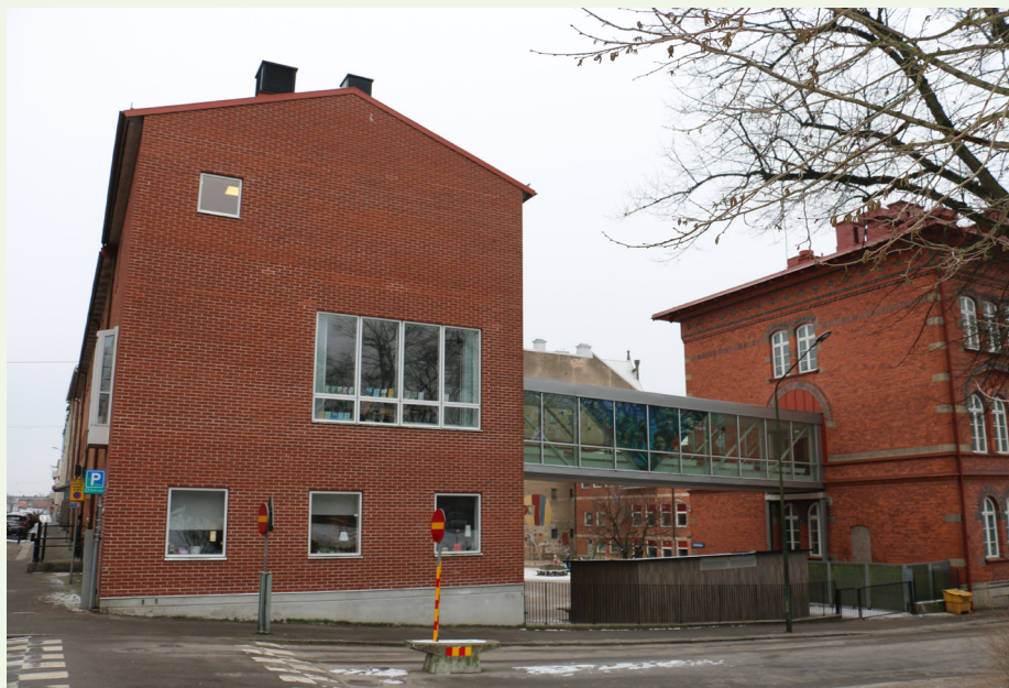
Tillbyggnad och gångbro, sett från Amiralitetstorget. Foto: Karlskrona kommun 2023.
