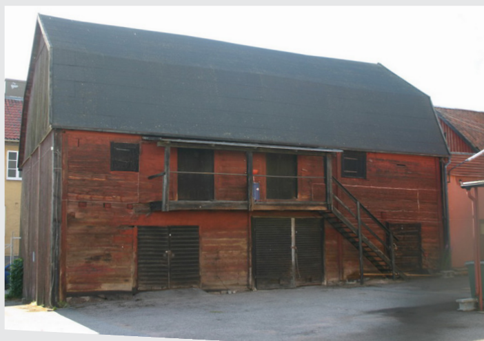
Hamnmagasin med brutet tak som låg längs Arvid Nilssonsgatan, norr om det idag bevarade magasinet. Foto från gårdssidan 2010. Källa: Blekinge museum.
