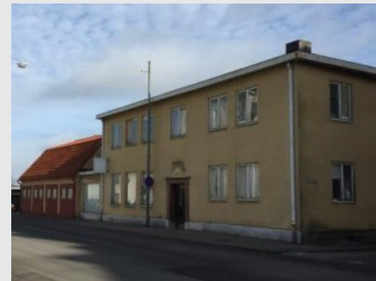
Byggnaderna längs Norra Smedjegatan. Odaterat foto. Källa: Planbeskrivning, Detaljplan för Gulin 1 m.fl. 2018.
