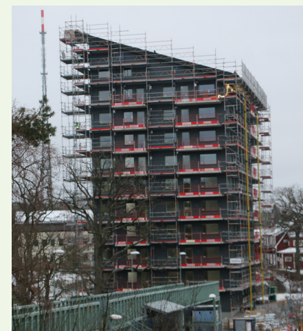
Pågående bygge av tiovåningshus. Foto: Karlskrona kommun 2023.
