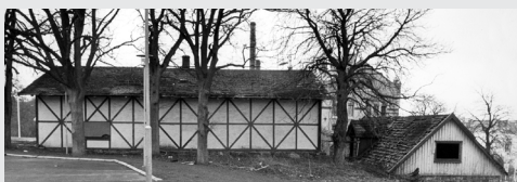
De båda byggnaderna från norr 1990. Källa: Blekinge museum.
