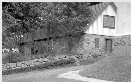
Den västra byggnaden 1962. Foto: Ingemar Atterman. Källa: Blekinge museum.
