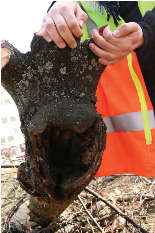
Felaktigbeskärning har orsakat röta och lett till instabila greninfästningar. Hoglands park.
