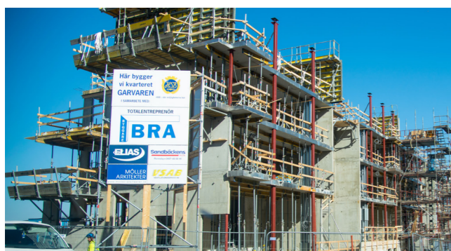
Skyltning i direkt anslutning till byggarbetsplats med information om konsulter och byggherrar är bygglovsbefriade.
