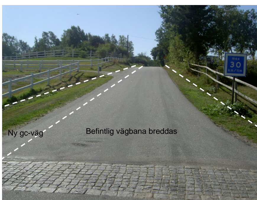
2. På denna sträcka ryms 2.5 meter bred gc-väg vid vägens östra sida, vilken bildar förlängning på befintlig gc-väg. Befintlig vägbana breddas för att möjliggöra föreslagna åtgärder.
